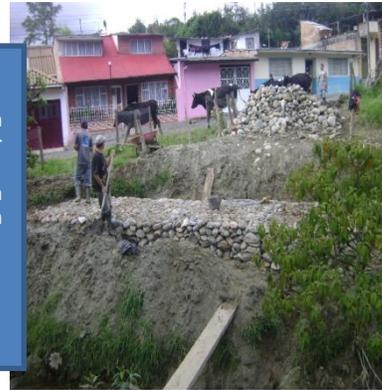
Foto No 23. y 24. Muro contención Quebrada Cofradía – Municipio de San Francisco.
